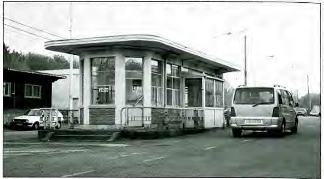
Noch vor Jahresende wird das ehemalige Zollhäuschen in den Besitz der Gemeinde Raeren übergehen und renoviert. Die VoE KuKuk hat damit ihr Ziel erreicht, den Kontrollpavillon vor dem Abriss zu bewahren und in einen Ort der Begegnung umzugestalten. Foto: Andres Rump
